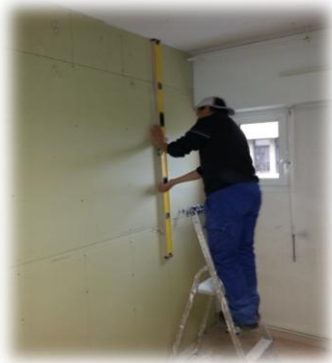
Pose de placoplâtre
